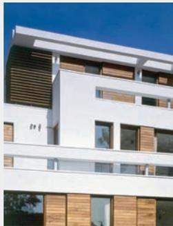
Système d'isolation thermique par l'extérieur avec enduits sur isolants collés au support
