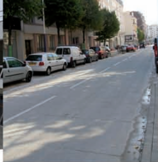
Rue Jean Bleuzen à Vanves (92) Chaussée en béton de 300 m Abattement significatif des gaz polluants Réalisée en Béton de ciment mince (BCMC) TX Aria®
