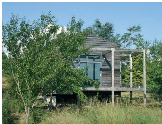
Maison Lormont, Saintes (17) : construite sur un terrain en pente elle repose sur des pilotis en béton. La structure du bâtiment est entièrement en bois, la couverture est en tôle acier. Le bardage en mélèze est non-traité.
