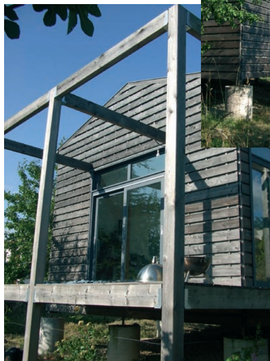
Maison Lormont, Saintes (17) : construite sur un terrain en pente elle repose sur des pilotis en béton. La structure du bâtiment est entièrement en bois, la couverture est en tôle acier. Le bardage en mélèze est non-traité.
