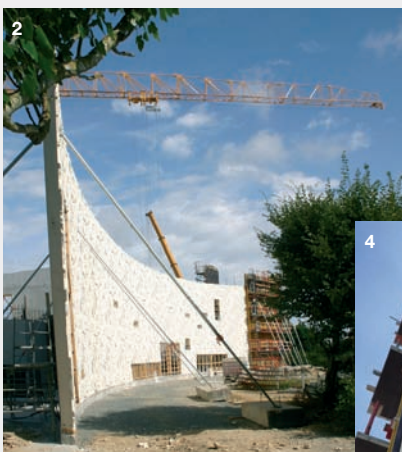
1) Perspective finale, façade sud 2, 3 et 4) Photos de chantier
