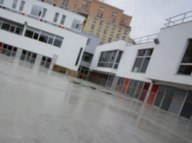
Ecole Camille Claudel à Courbevoie (92) Valero/Gadan MO : Ville de Courbevoie Réalisée en béton TX Aria®
