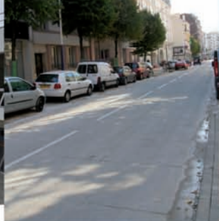
Rue Jean Bleuzen à Vanves (92) Chaussée en béton de 300 m Abattement significatif des gaz polluants Réalisée en Béton de ciment mince (BCMC) TX Aria®
