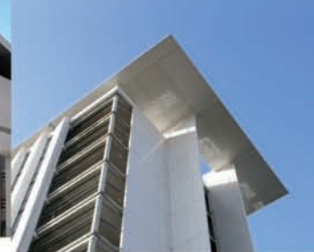
Tour Headlight à Labège (31) Dain/Saladin MO : Carle Investissements et Réalisation Réalisée en béton TX Arca® blanc
