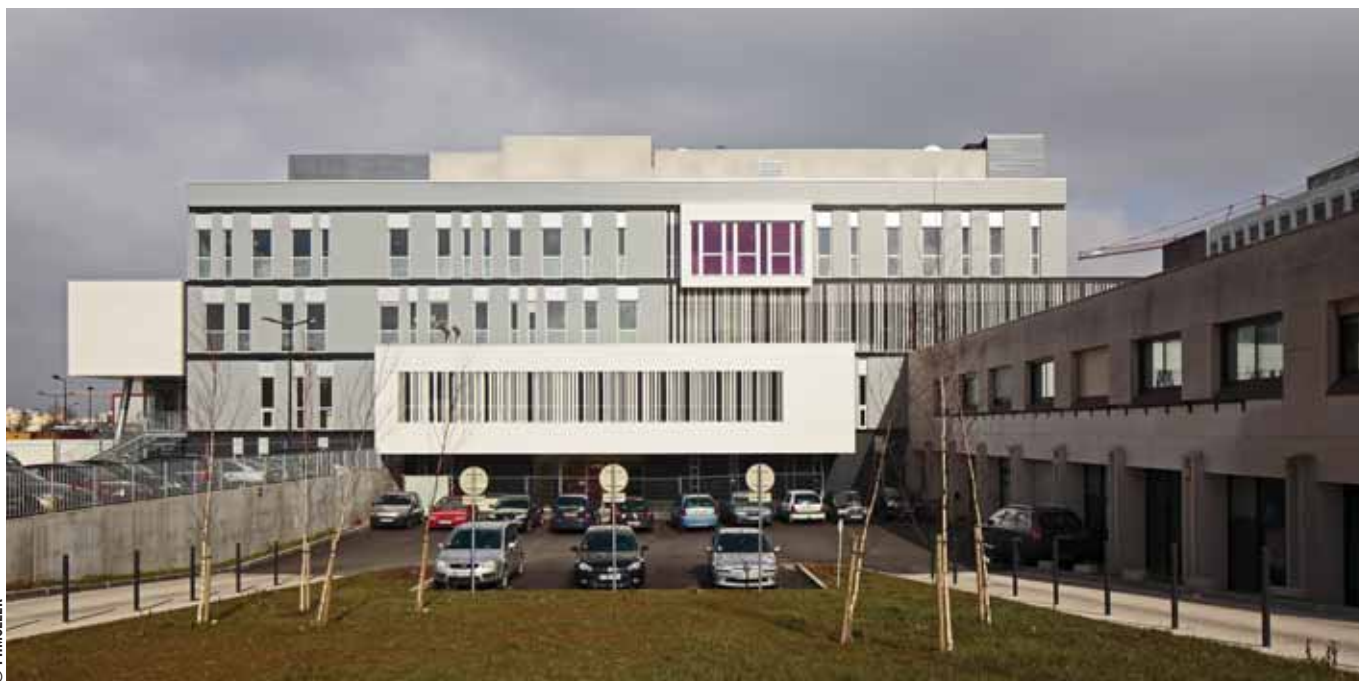
Hôpital Privé de l'Ouest Parisien, Trappes (78) - 2013
