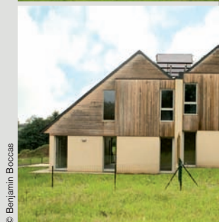
Premières maisons jumelées réalisées
