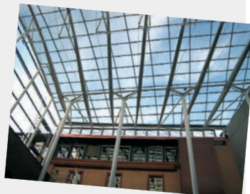
Palais de Justice de Toulouse en chantier (31)
