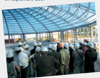
Stade aquatique de Vichy en chantier (03)
